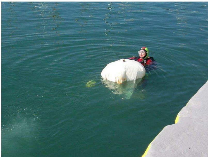
Foto 2 - Palloni di sollevamento per il recupero dei materiali pesanti.
